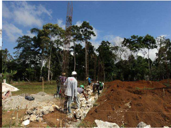
maçonnerie de fondation
